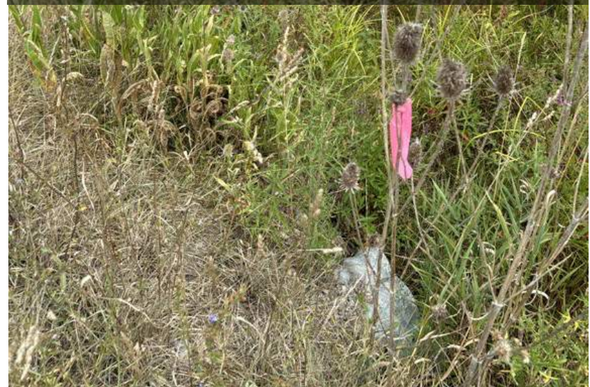
7495 Chaffee Rd culvert (CEI parcel) = 12" U/S end
